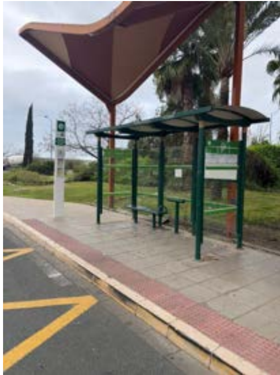
Sevilla, reposición poste nuevo en Chapina.
