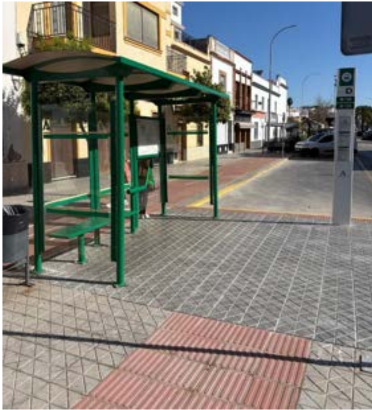
Gerena, instalación poste nuevo en calle Sevilla.
