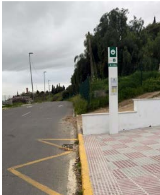
Tomares. instalación postes nuevos en calle Camino Viejo y Avda. de Cala
